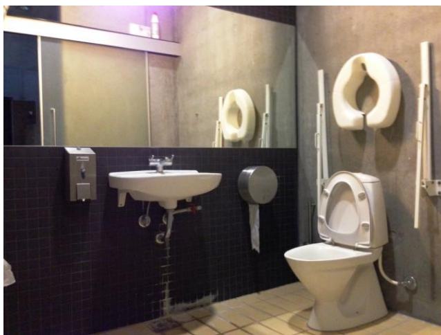
Billede 17 - Toiletforholdene i omklædningsrummet
