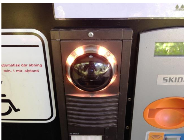
Billede 12 - Samtale anlæg med kamera – Lyser ved kontakt
