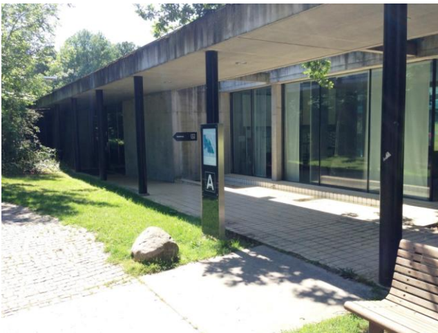
Billede 7 - Indgang A med rampe ned til indgangspartiet
