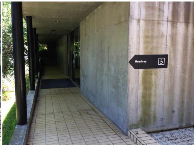
Billede 8 - Adgangen ned til indgangspartiet ved indgang A
